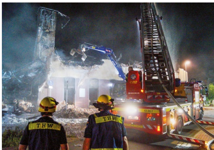
Zusammenarbeit: Maschinen des THW (Radlader und Bagger) erleichtern durch die Abrissarbeiten die Nachlöscharbeiten der Feuerwehr.
