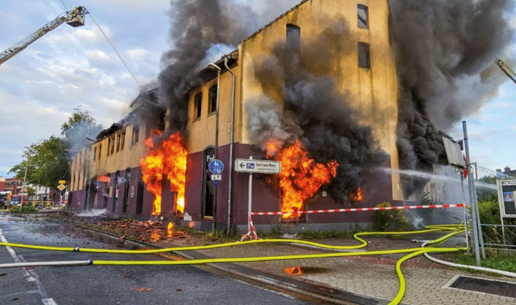
Brandausbreitung: Während der Brand im Dachgeschoss bekämpft wird, kommt es an einer Gebäudeseite im Erdgeschoss zur Durchzündung.
