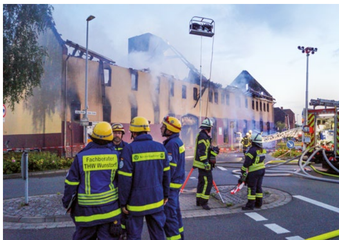
Gegen 21.20 Uhr: Das Feuer ist im Großen und Ganzen erst einmal niedergeschlagen. Die noch anstehenden Nachlöscharbeiten werden noch viele Stunden dauern.
